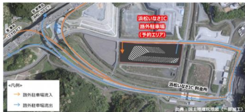
新東名(引佐連絡路)浜松いなさ路外駐車場
