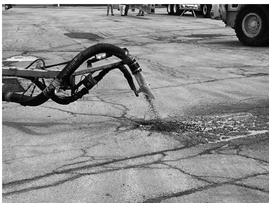
写真一5 路面補修車両
